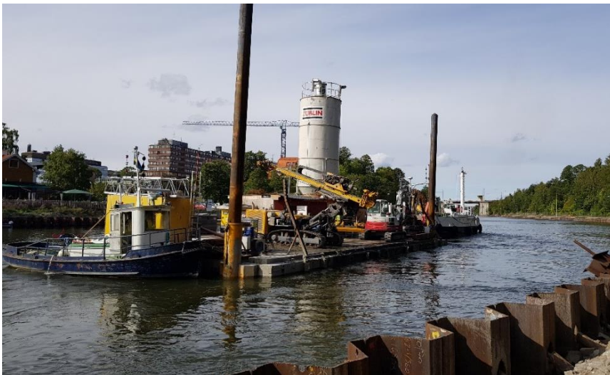
Züblin Spezialtiefbau GmbH | Södertälje, Sweden
